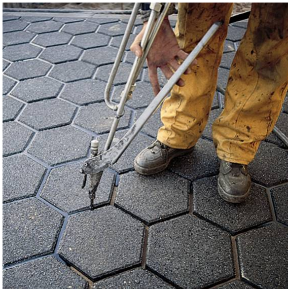
Foto: Voorbeeld van het aanbrengen van voegvulmassa.
